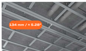
Minimalus montavimo plotis tarp profilių: 134 mm / ≈ 5.28"
