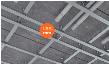
Minimalus montavimo plotis tarp profilių: 135 mm / ≈ 5,31".
