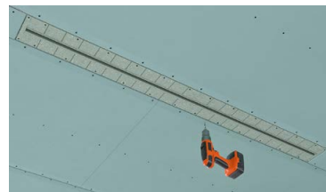
Svarbu: montavimo metu visi tvirtinimo varžtai turi būti susukti.
