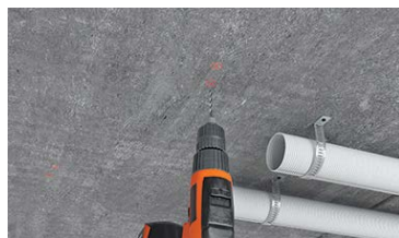
Montuojamas į gipso plokščių lubas bei sienas.
